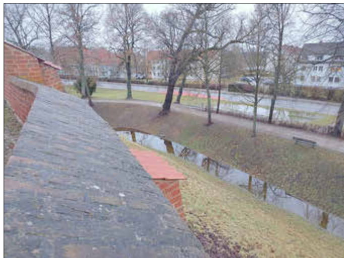
Bild vom 22. Februar 26, von der Stadtmauer „Hinter der Kirche 1“ Foto: Uwe Seppmann
