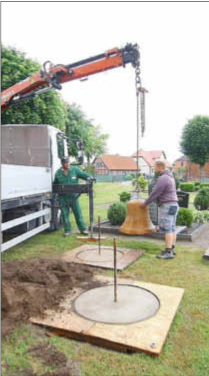
Die Eisenhartgussglocken werden auf Betonfundamenten befestigt
