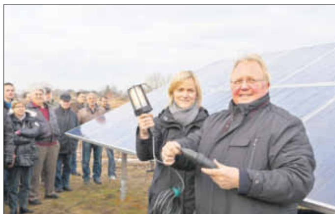
Die NEG-Vorstände Cornelia Meissner und Rolf Bemann prüfen die Betriebsbereitschaft der Photovoltaikanlage auf der Deponie Paarsch mit dem so genannten „Glühlampentest“.
