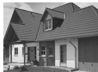
Wenn die Dachfläche zum Katalysator wird: Die Frankfurter Pfanne Titano/x von Braas reinigt die Luft. Foto: Braas
